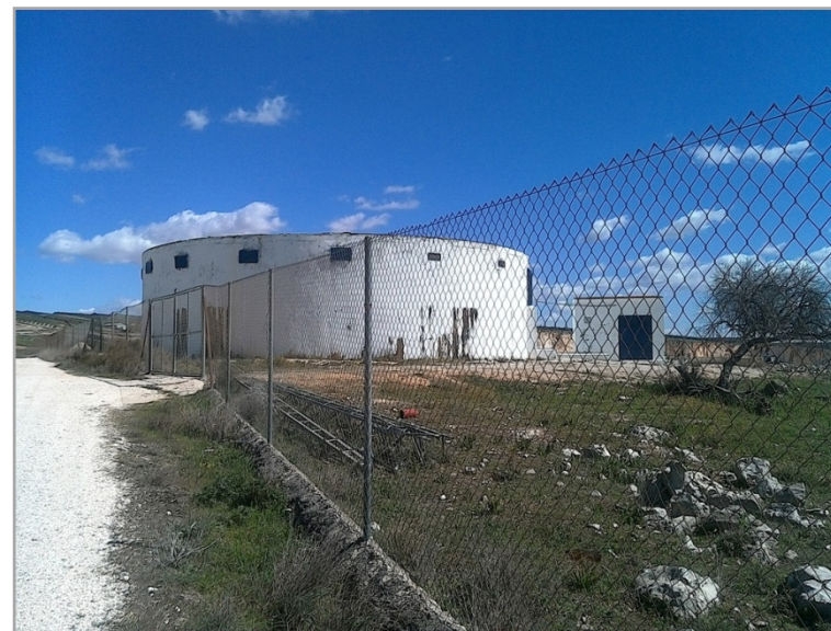
Vista de los depósitos generales de abastecimiento de la localidad.
