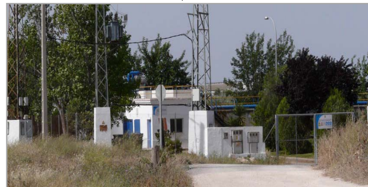
Vista del acceso a la EDAR desde el paso a nivel de la línea de ferrocarril.
